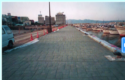
別府楠港船揚場（平成3年施工）
