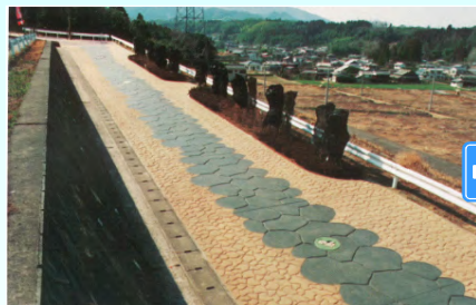
判田ペデストリアン（平成2年施工）
